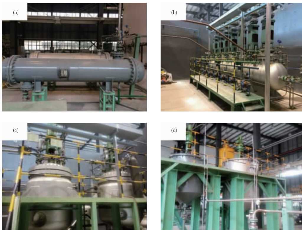
(a) 矿浆及硫酸储槽; (b) 矿浆及硫酸加热器; (c) 加压浸出反应釜主体; (d) 调试槽与闪蒸槽
